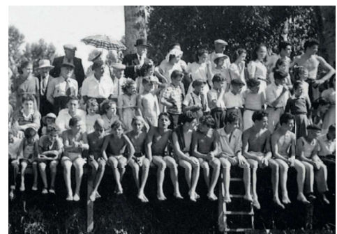
... comme les pontons de Mouille-Cul, en limite de Magné.
